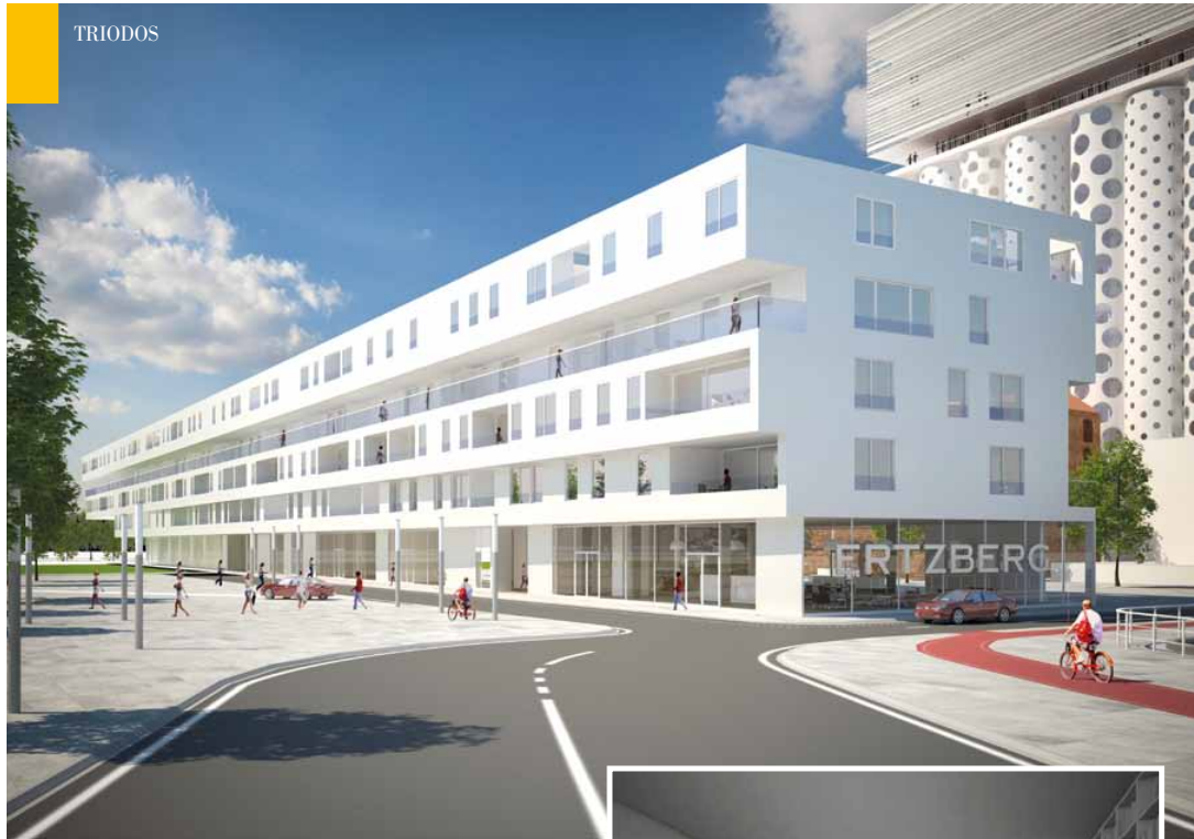
De Balk van Beel kreeg als eerste residentiële gebouw op het Europese vasteland een BREEAM 'outstanding'-certificaat.
